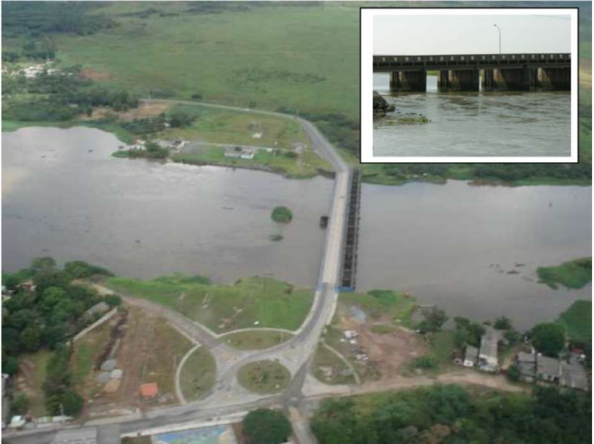
Figura 5.4 – Vertedouro do Valo Grande. À direita detalhe mostrando o fluxo das águas do rio por suas colunas.
