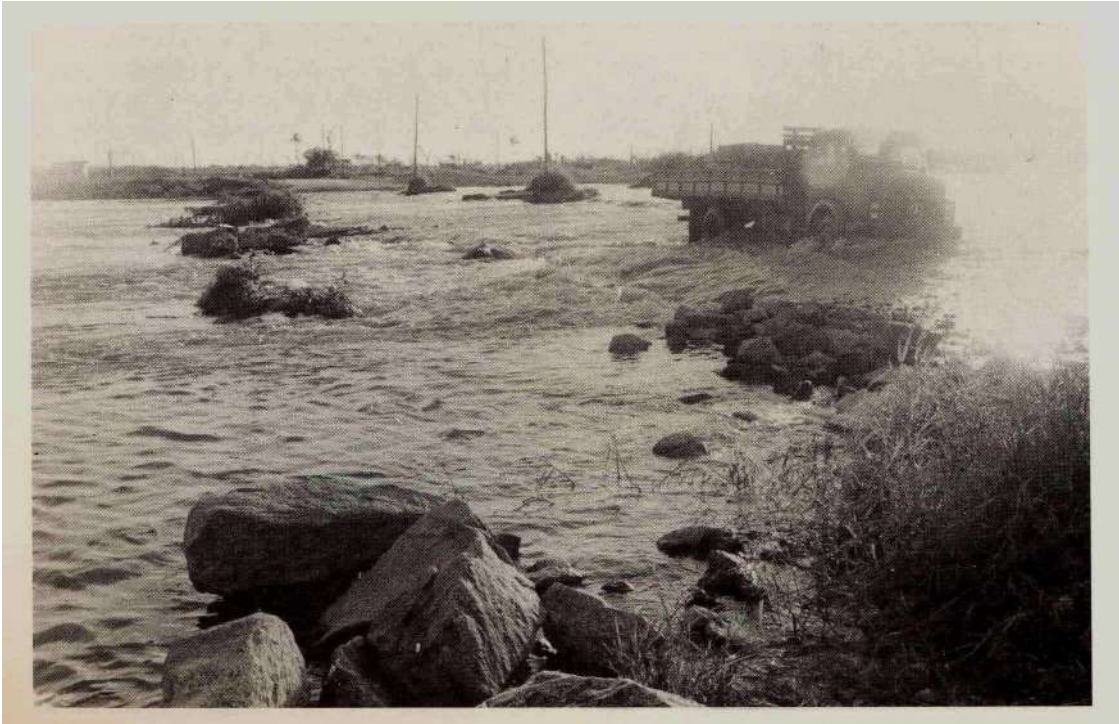
Figura 5.2 – Aspecto da barragem do Valo Grande rebaixada com galgamento das águas. Final da década de 80.
